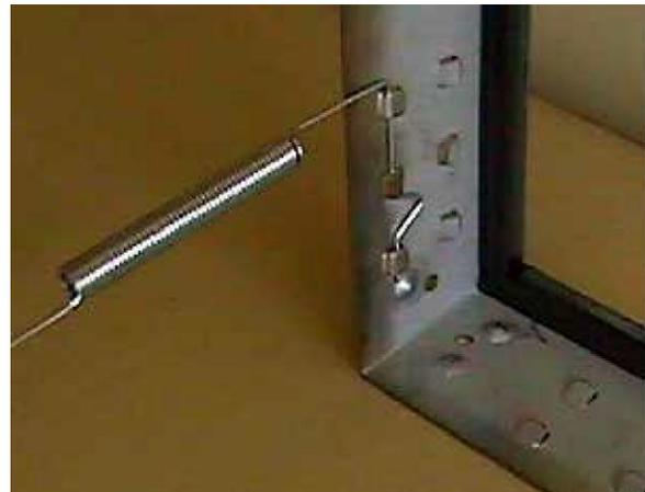
**FIGURE 115 - CORRECT LATCHOUT/KNOCKOUT CONFIGURATION**
