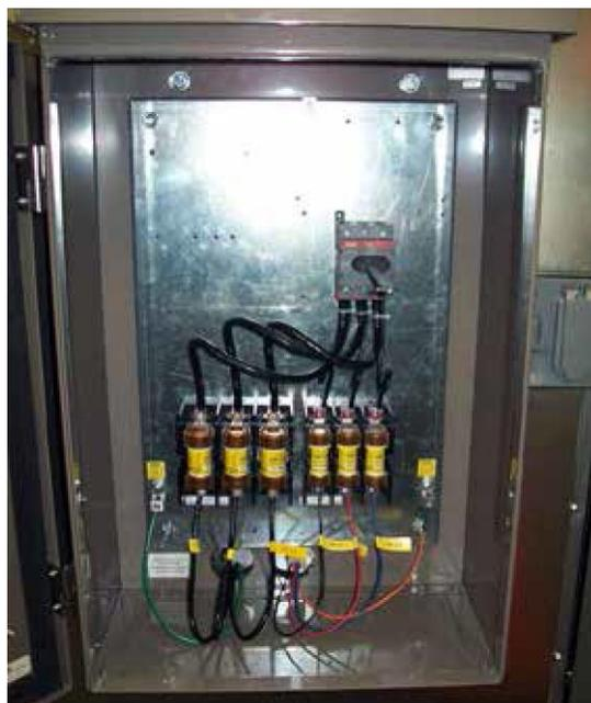
**FIGURE 61 - SINGLE POINT POWER CONNECTION**
