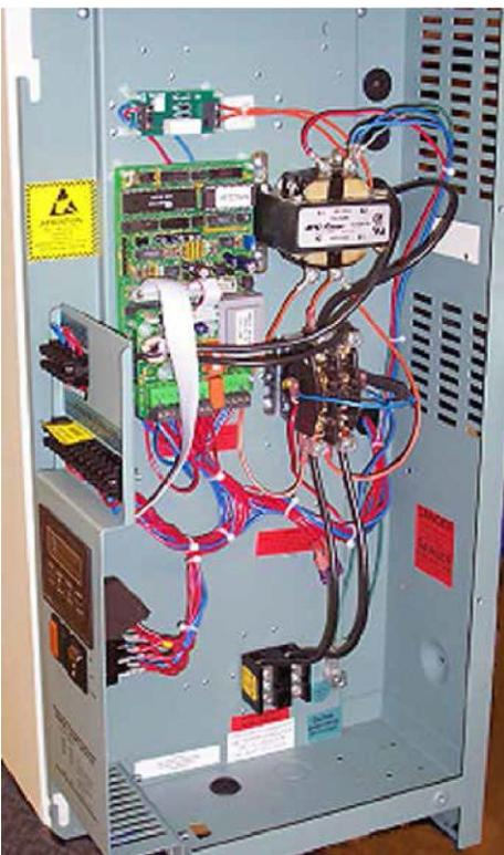
**FIGURE 72 - LAYOUT OF TYPICAL HUMIDIFIER PANEL**
