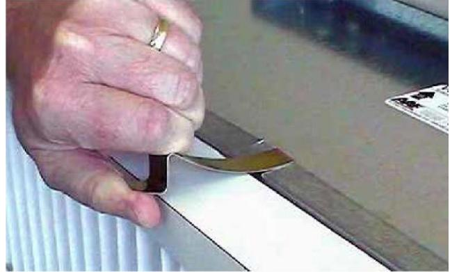
**FIGURE 121** - POSITION PRE-FILTER IN FRONT OF FINAL FILTER
